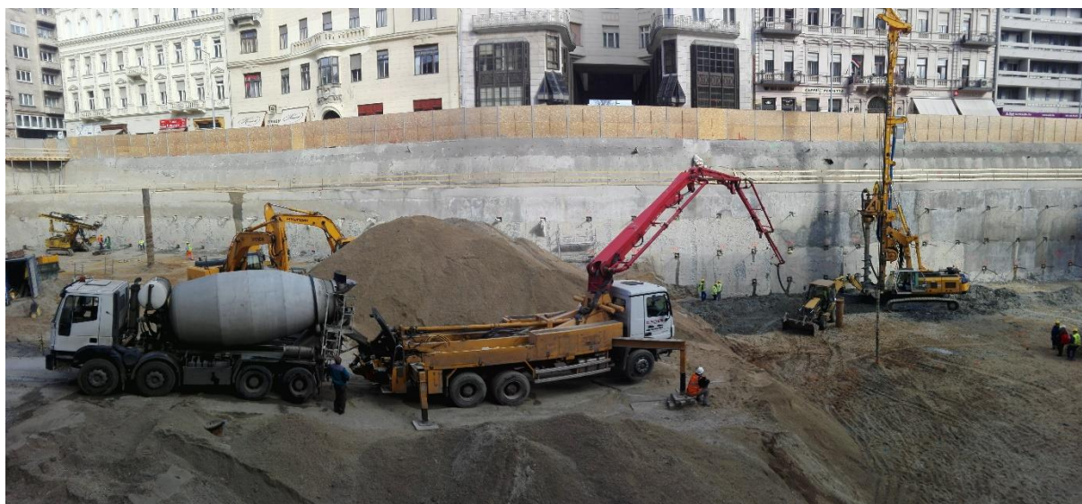
9. ábra: Mélygarázs építési munkálatai
