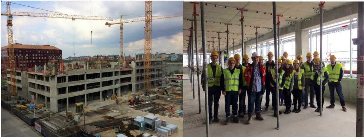
35. ábra: Építési helyszín
