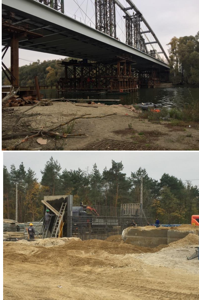
49. Ábra: A híd kivitelezése
