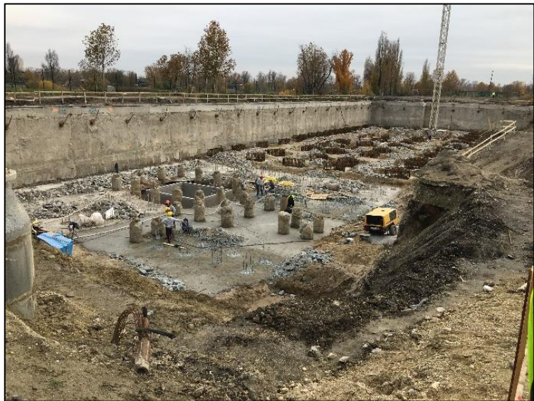
50. Ábra: Az építkezés aktuális állása
