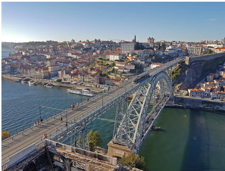
62. ábra: Ponte Luiz híd
