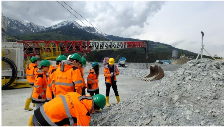
40. ábra: Felszíni munkálatok megtekintése.
